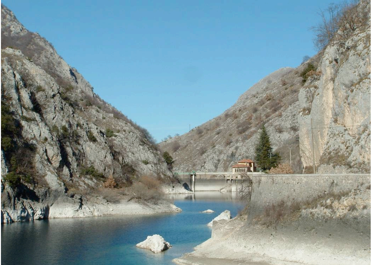
Figura 14 - San Domenico. La diga artificiale è stata ultimata nel 1929, le acque attraverso una galleria a condotta forzata (6 Km di lunghezza) alimentano le turbine idroelettriche del Sagittario situate a 3 km dopo dell'abitato di Anversa degli Abruzzi.
